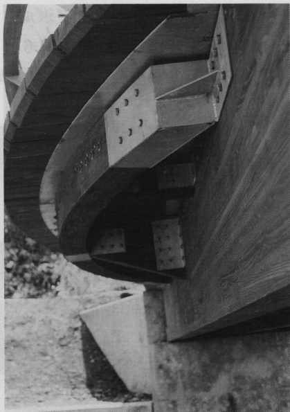
写真1 鋼製防水カバーを設置した桁
