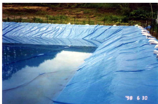
写真2 終了前のシート状態(1999.11.4)
