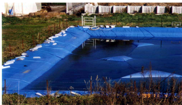
写真1 雨水分離シート設置直後(1998.6.30)
