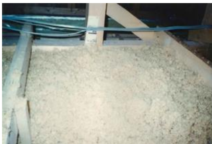
(a) 施工時写真
