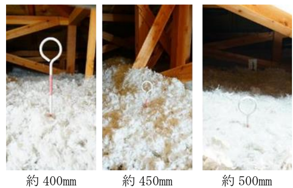
図 3-10 厚さ測定状況
