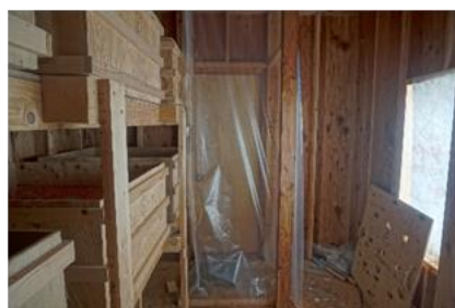
図 3-2 シート設置状況
