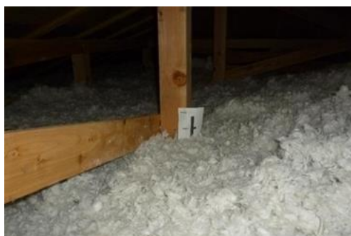
(a) 施工時写真
