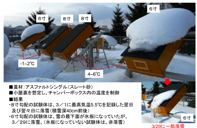
写真1 春先の融雪過程における屋根の積雪状態
