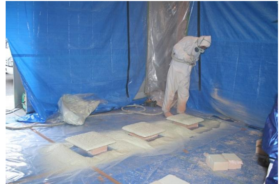
図1 標準施工実験の様子
