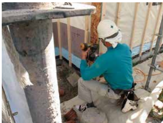
写真16 外側垂木留め付け
