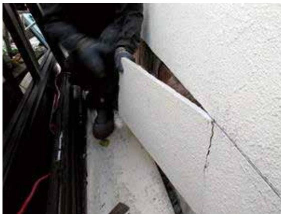
写真 4 モルタル撤去
