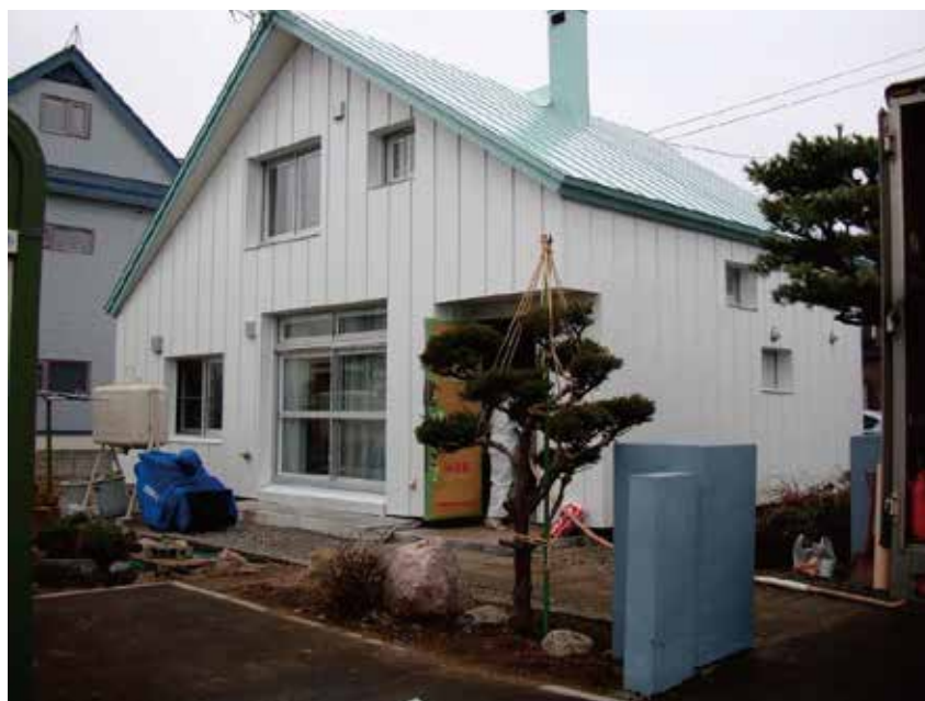
改修後の外観
