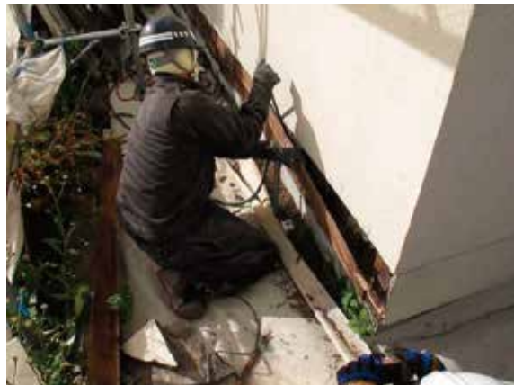
写真6 下地板撤去
