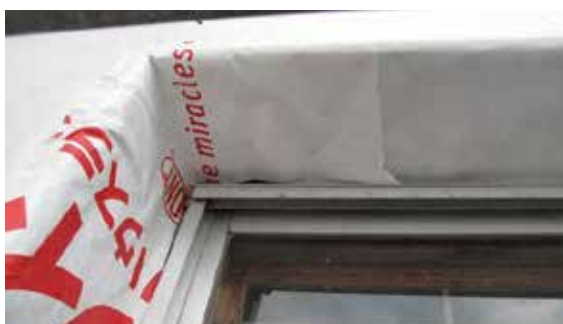
写真 2 5 透湿防水シート 窓周り
