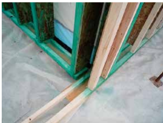
写真20 壁ふかし出隅の施工
