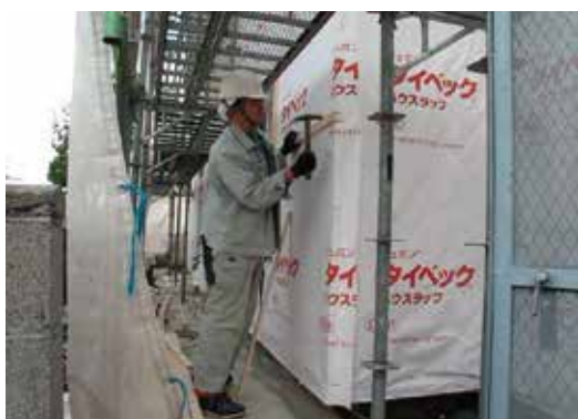
写真 2 7 通気胴縁釘打ち
