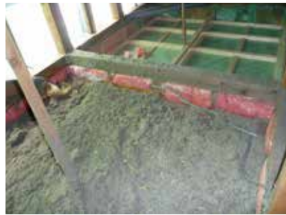
間仕切壁上部の気流止め 施工状況
