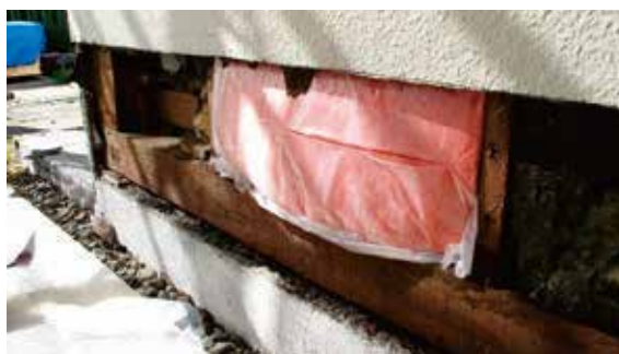
写真 9 気流止め材切り込み
