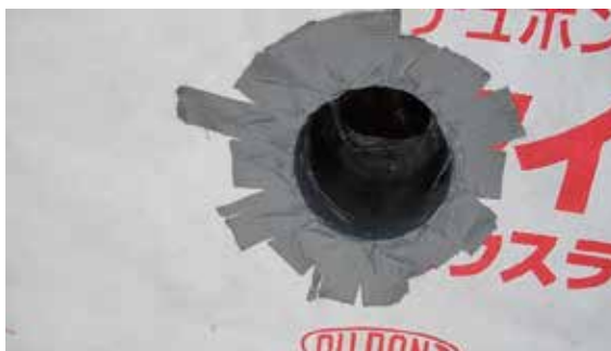
写真 2 6 透湿防水シート 配管周り
