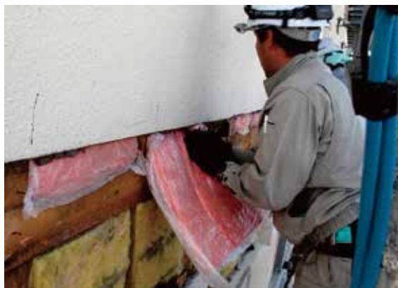
写真 8 気流止め材挿入
