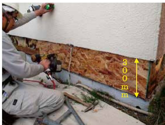
写真 10 O S B 合板張り土台周り
