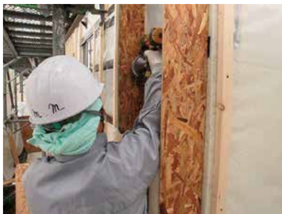
写真17 ふかし下地の固定
