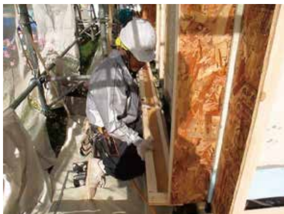
写真19 壁ふかし土台周り
