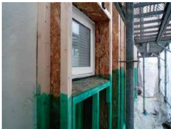
写真18 壁ふかし窓周り
