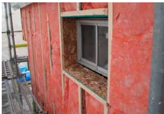
写真 2 2 窓周りの断熱施工
