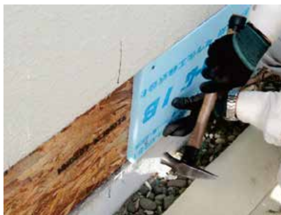
写真１２ ＸＰＳ板による不陸調整
