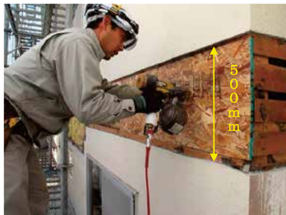
写真１１ ＯＳＢ合板張 桁周り
