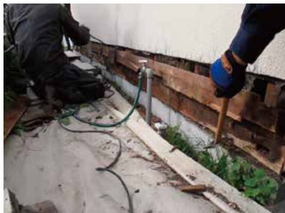
写真7 躯体の打診検査
