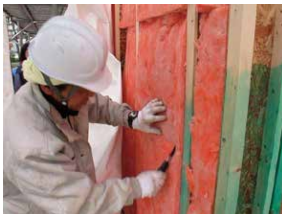
写真 2 3 断熱材の切込み
