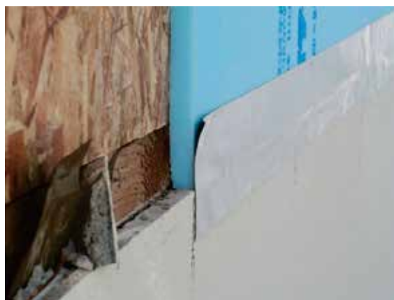
写真１３ ＸＰＳ板の防水
