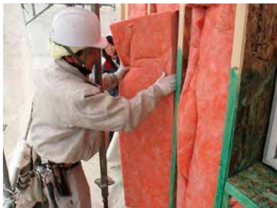
写真 2 1 グラスウール挿入
