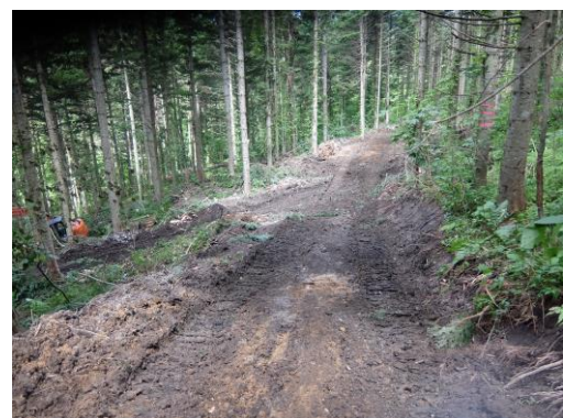
写真-4 修繕した道の様子
