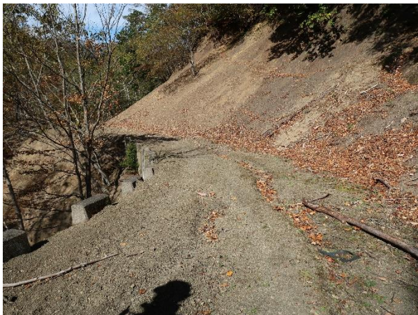
写真-11 盛土のり面に設置された擁壁
