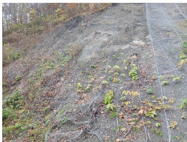
写真-12 切土のり面に掛けられたネット
