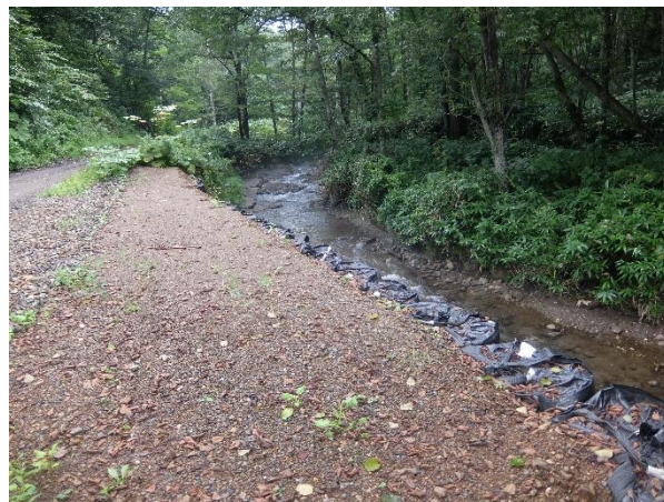
写真-14 大型土嚢による盛土のり面保護
