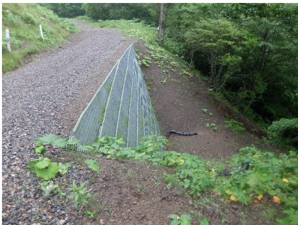
写真-13 盛土のり面保護工
