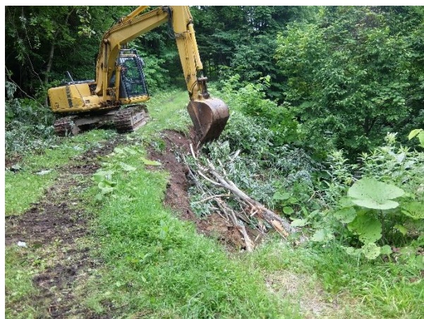
写真-15 盛土のり面崩壊の復旧
