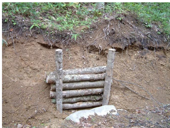
写真-19 呑口保護の簡易な方法
