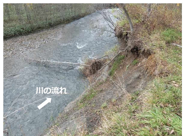
写真-7 溪岸侵食（崩落）
