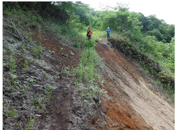
写真-1 表層崩壊タイプ
