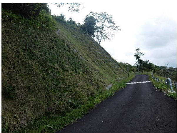
写真-11 切土のり面に施されたフレーム工法
