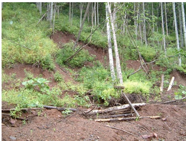
写真-3 立木ごとと表層土が崩れた事例
