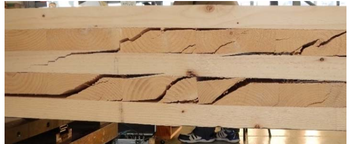
図3 ローリングシアによって破壊した直交層のラミナ
