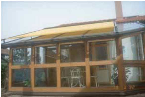
写真6 ガラスの屋根の日よけ
