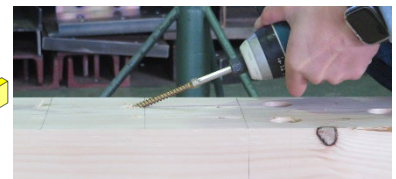
写真2 ビスの打込みの様子
