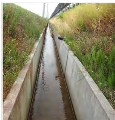
擁壁型用水路
