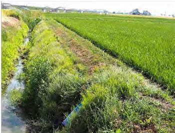
水路から水田までの植生の連続性が確保された水路
