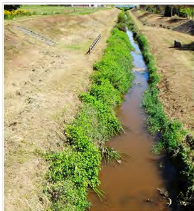
除草剤を使用した排水路法面 水際の植生は残されている
