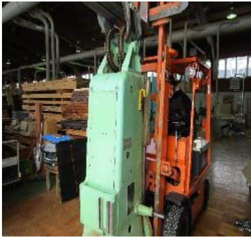
木工機械の解体作業
