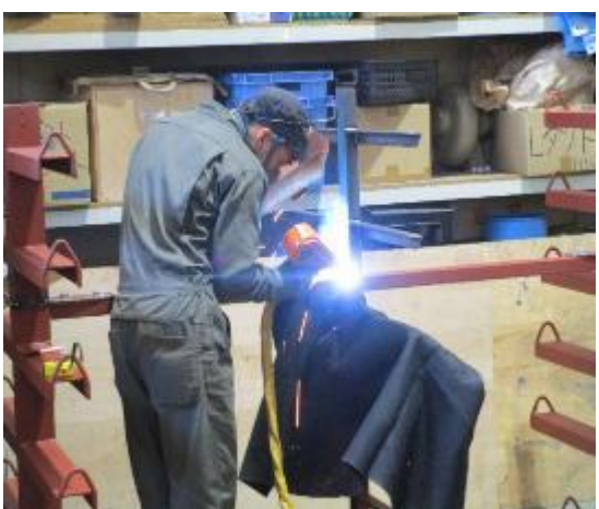
鋼材置き場での溶接作業
