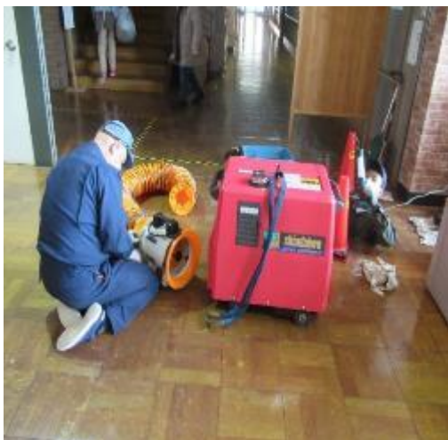
配管蒸気漏れ補修作業①
