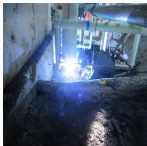
配管蒸気漏れ補修作業②
