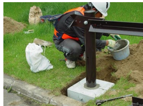
写真7 支柱と根巻きコンクリートの固定
