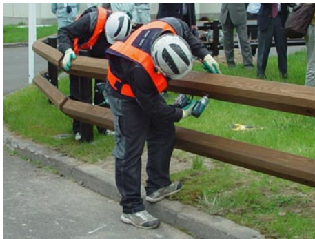
写真10 集成材の固定
