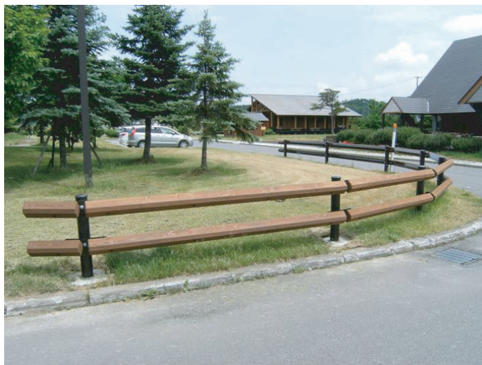
北海道型木製ガードレール『ビスタガード』 (林産試験場構内, 6月3日設置)
