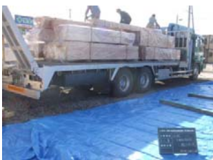
期日内現場搬入
