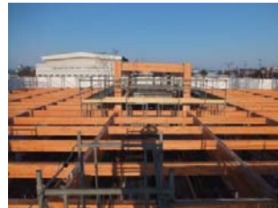
大断面集成材建込完了
