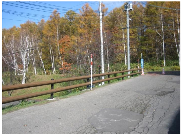
写真1 北海道型木製ガードレール（東神楽町）
