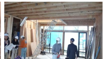
2×4住宅での施工事例 (I形梁・スパン6m)
