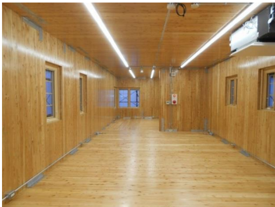
写真2 CLTによるセミナーハウスの内部（北見市）
