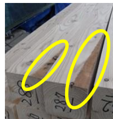
図1 修正加工後の削り残し(線で囲った部分が削り残し)
