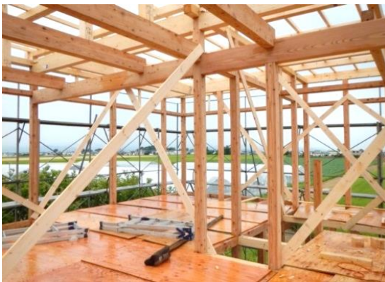
写真1 コアドライによる建築
