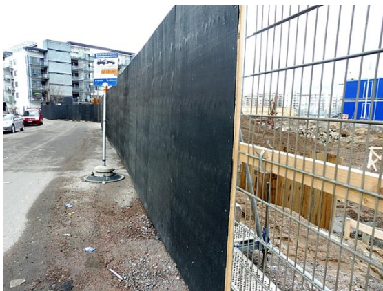
写真15 建設工事現場に設置された仮囲い
