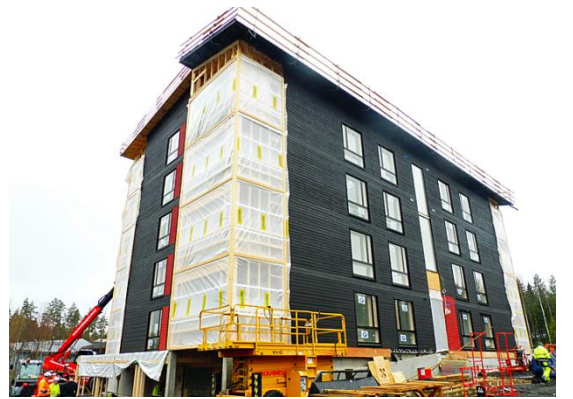
写真11 セイナヨキで建設中のCLT集合住宅
