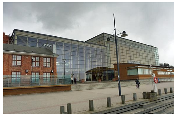
写真8 木造のコンサートホール（外観）
