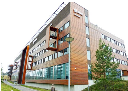
写真5 木造オフィスビル
