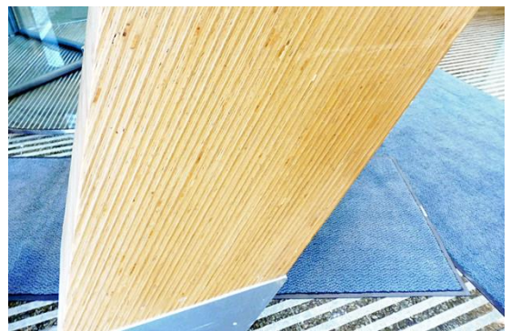
写真7 斜めにカットされたLVLの柱脚部分
