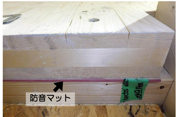
写真12 階段室に使用されたCLT
