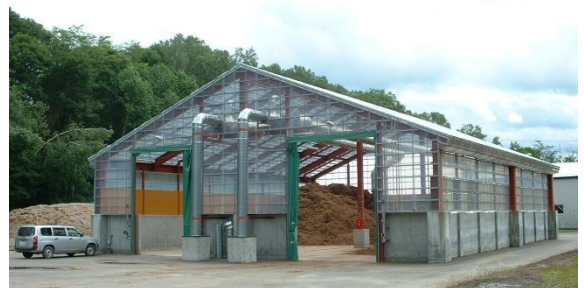
写真 チップ乾燥施設（南富良野町）
