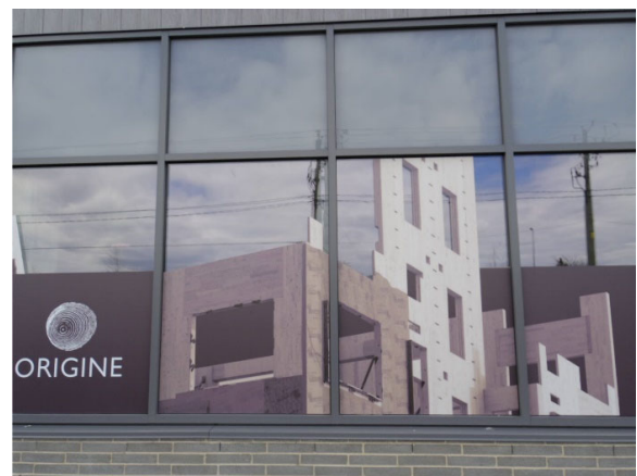
写真8 建設途中の建物の写真
