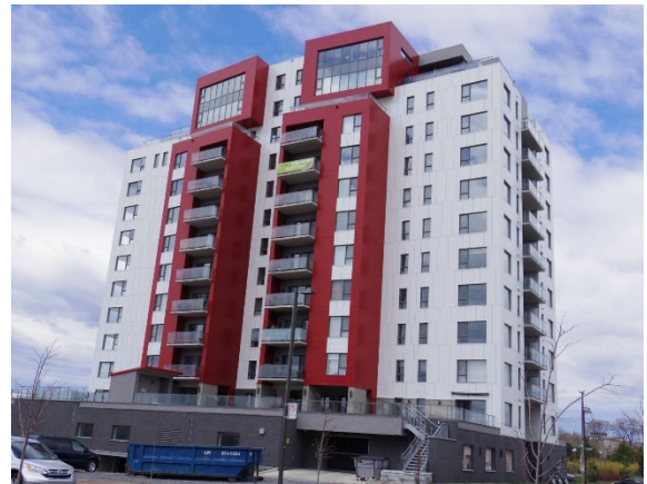
写真7 CLT製木造高層住宅（1階部分RC造）
