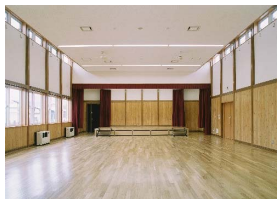
境野公民館（置戸町）＜壁にCLTを利用＞
