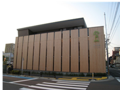
写真1 LVLを用いた仮囲い（上）と外壁（下）
