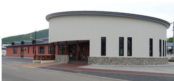
写真1 建物の外観 (円筒系のドーム部分内に地域交流スペース)
