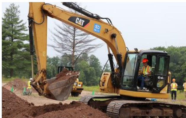
【車両系建設機械技能講習の様子（7月21日撮影）】
