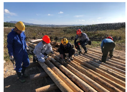
【防風柵の設置（檜山管内）】
