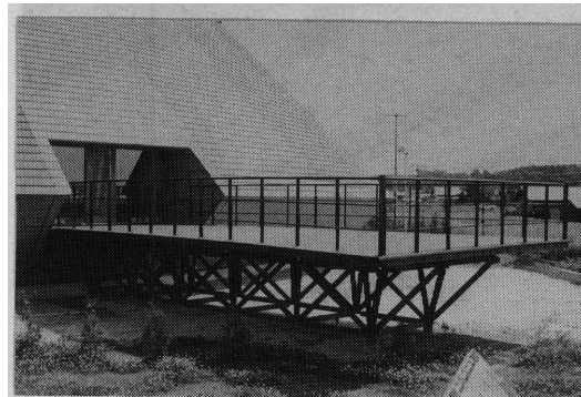
写真6 完成した外部木デッキの全影
