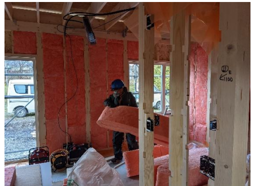
木造住宅の断熱材充填作業
